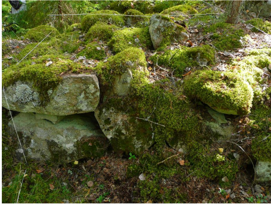
3. Kaivausalueen 1 ladottua kivimuuria kalliopohjalla. Kuva lännestä.
